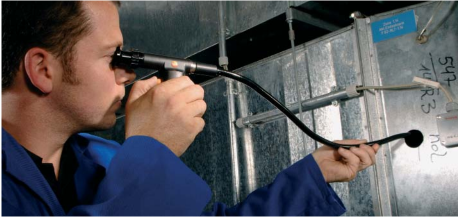
Kontrola kanálů s husím krkem - střední ohebnost.
